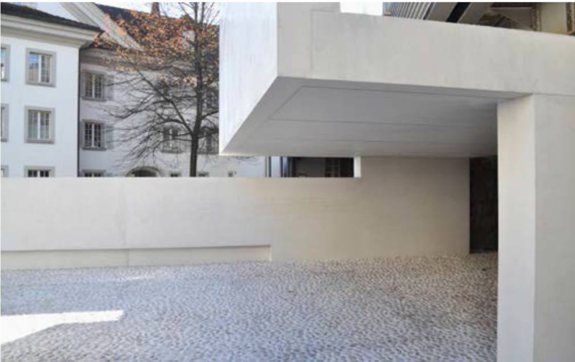
Neubau Talstation Gütschbahn, Luzern, Schmid Bauunternehmung AG, Ebikon
