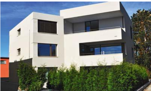
MFH Bankstrasse Hochdorf, Schmid Bauunternehmung AG, Ebikon
