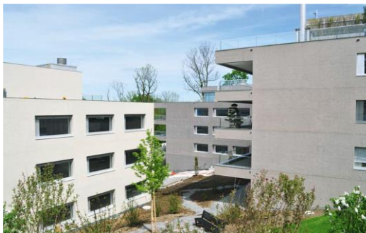
Kalksteinbeton Hänibüel, Zug, Landis Bau AG, Zug
