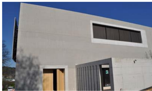
Zentrum Höfli, Ebikon, Schmid Bauunternehmung AG, Ebikon
